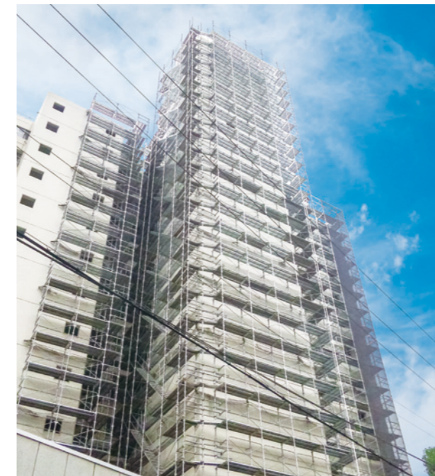
53mの施工実績写真 → 中高層のビルの高さは31mと45mが多い ※施工現場によって補強なしでの高さは異なります
